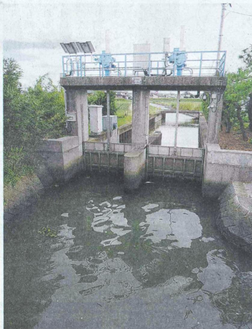
上 水門の開閉を遠隔操作できるようにした福岡県遠賀町の平田川井堰
