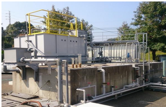
既設流用 20Ton/日処理 H27年度 (食品加工排水)
