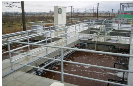
新設 60Ton/日処理 H24年度 (食品加工排水)
