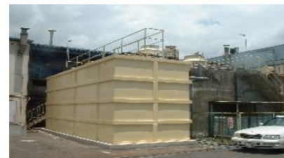
既設流用+鋼板槽
