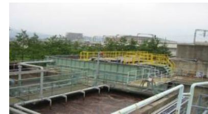
Hệ thống dẫn dòng có sẵn + Bể thép
